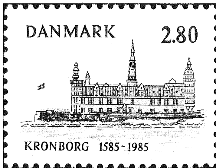
□ Fig. 27. Kronborg slott i Helsingør.
